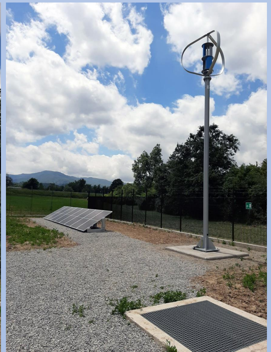
TURBINA EÓLICA 700W - INSTALACIÓN DEL SISTEMA HÍBRIDO EN EL LUGAR DE ALMACENAMIENTO DE GAS SNAM
