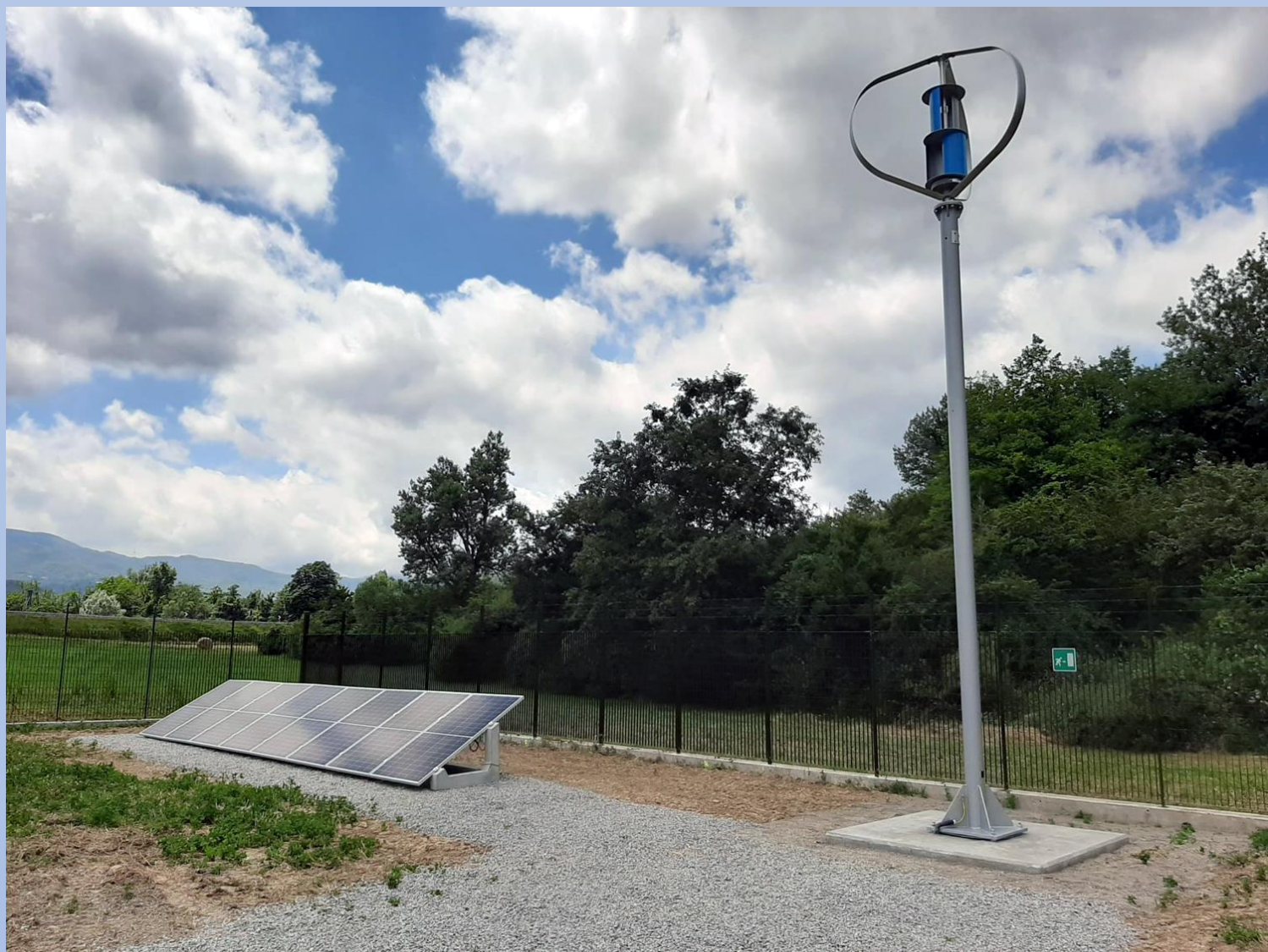
TURBINA EÓLICA 700W - INSTALACIÓN DEL SISTEMA HÍBRIDO EN EL LUGAR DE ALMACENAMIENTO DE GAS SNAM
